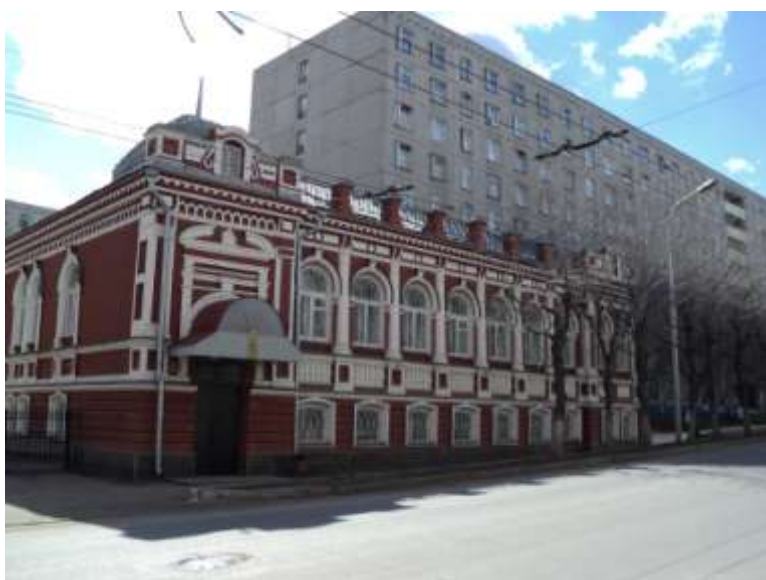
Здание по адресу: ул. Коммунистическая, 34, где находится Правление Союза писателей РБ.
